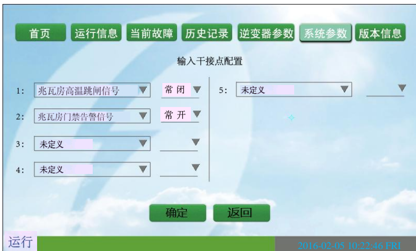
图 5-12 兆瓦房告警配置
